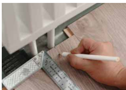
Marco de puerta y tubos de calefacción
